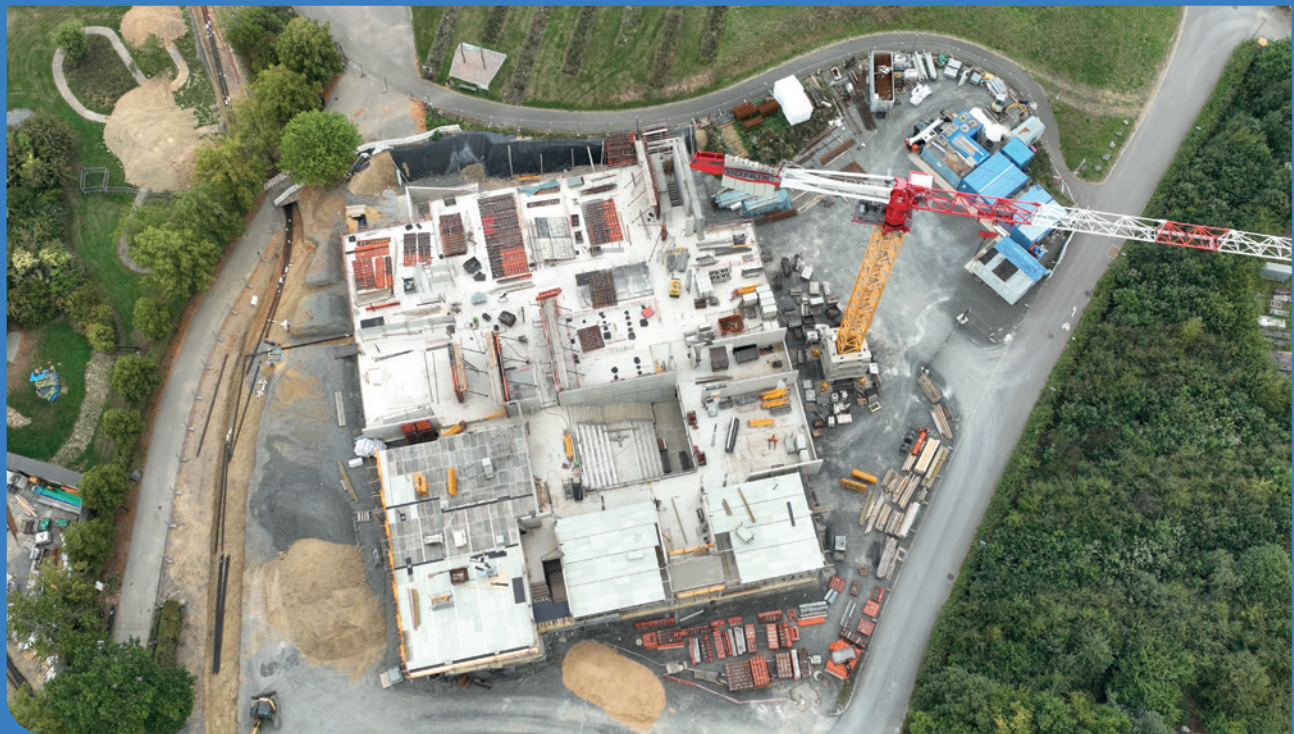
2) Chantier Ausbau Cyclen 2-4
