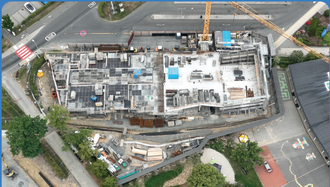
1) Chantier Ausbau Cycle 1
